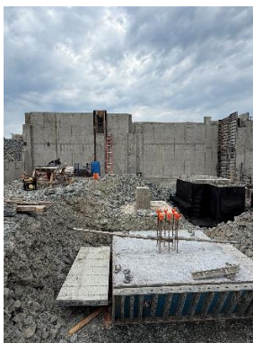
High foundation wall pour completed
